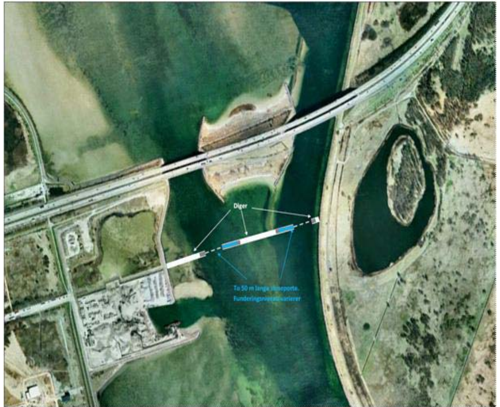
Figur 15: Dæmning og sluse ved Kalvebodløbet.
