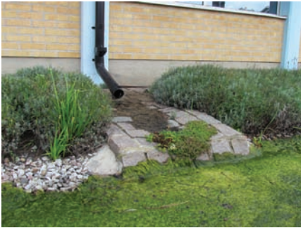
Figur 1: Regnvand ledes i en tæt rende bort fra huset til nedsivning i græsplænen. Augustenborg, Malmø. Foto Orbicon.
