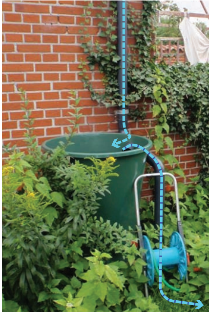
Figur 7: Tagvandet ledes via nedløbsrøret til regnvandstønden. Når tønden er fuld, ledes vandet i overløb til et andet nedsivningselement i haven. Tønder fås i flere varianter, og kan som i dette tilfælde skjules af beplantning. Slagslunde, Egedal Kommune. Foto Orbicon.
