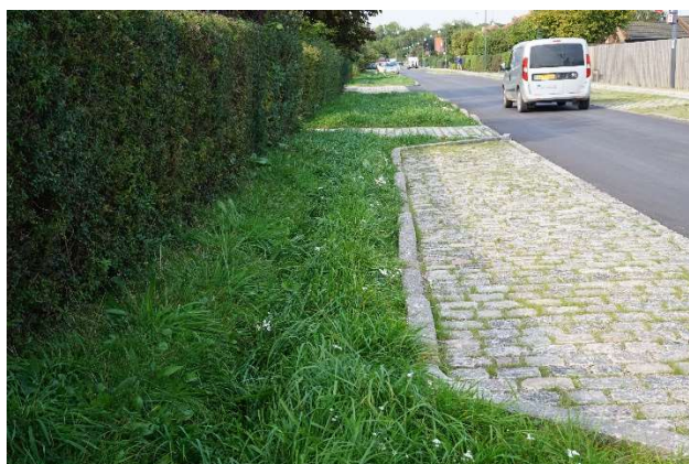
Figur 7: Regnbede og grøft på Lørenskogvej, Rødovre
