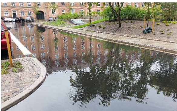
Figur 4: Billeder af hævede kantsten omkring Tåsinge Plads i skybrud juni 2015
